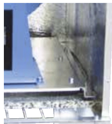
Montert på vibrasjonsdempere.
