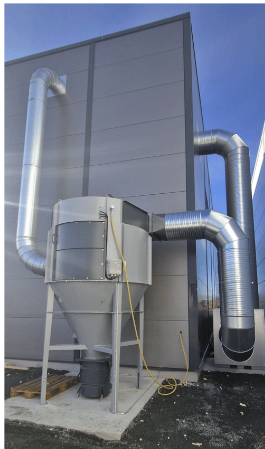
Bilde: ACF-234H med 148 liter beholder. Galvanisert+pulverlakkert for utendørs montering. RV 80-C2 vifte i VB lyddempende kabinett.
